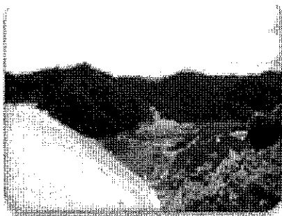
〈그림-4〉 콘크리트 차수벽형 석괴댐
